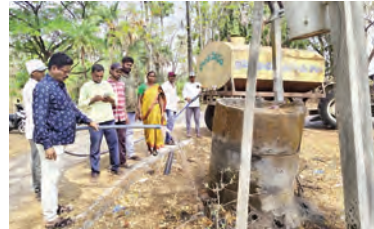
కోసిని గ్రామపంచాయతీ పరిధిలో ఇళ్లలో సరైన ఎర్లింగ్ అందక ప్రజలు ఎదుర్కొంటున్న సమస్యలను దృష్టిలో ఉంచుకుని ప్రత్యేక కార్యక్రమం నిర్వహించారు.
